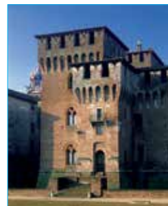
■ Nella foto più grande, Piazza Sordello, poi Mantova dall'alto, vista iniziando dal Lago di Mezzo e una parziale del Castello di Sangiorgio.
